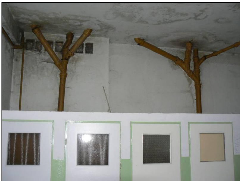
Fot. 4 Budynek II Liceum Ogólnokształcącego przy ul. Sportowej
