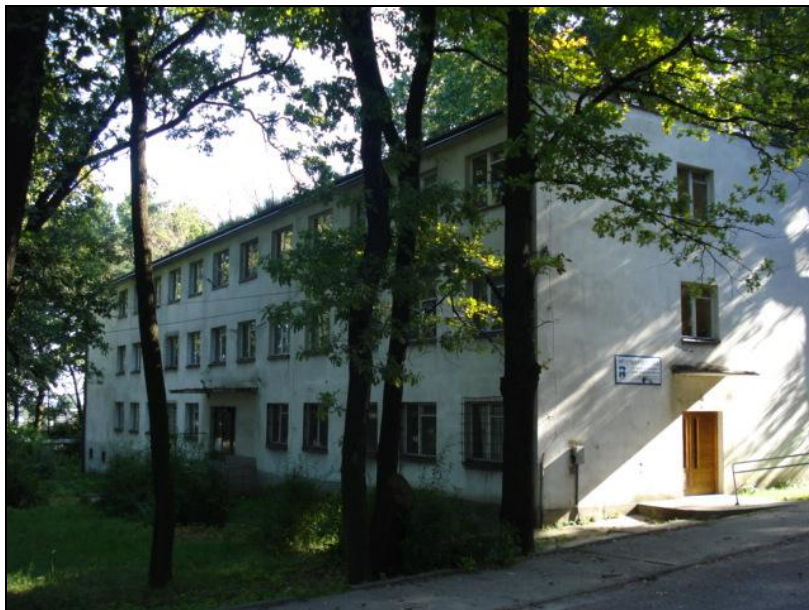
Fot. 2. Budynek po byłym biurowcu firmy Resbud przy ul. Kwiatkowskiego.
